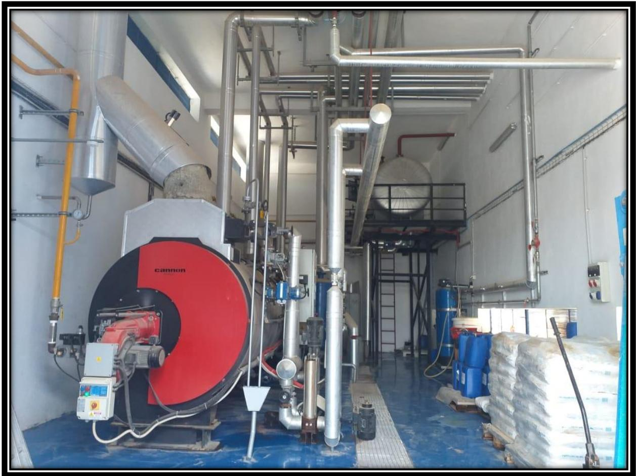
*Figure 35 : Station de la chaudière à vapeur*
