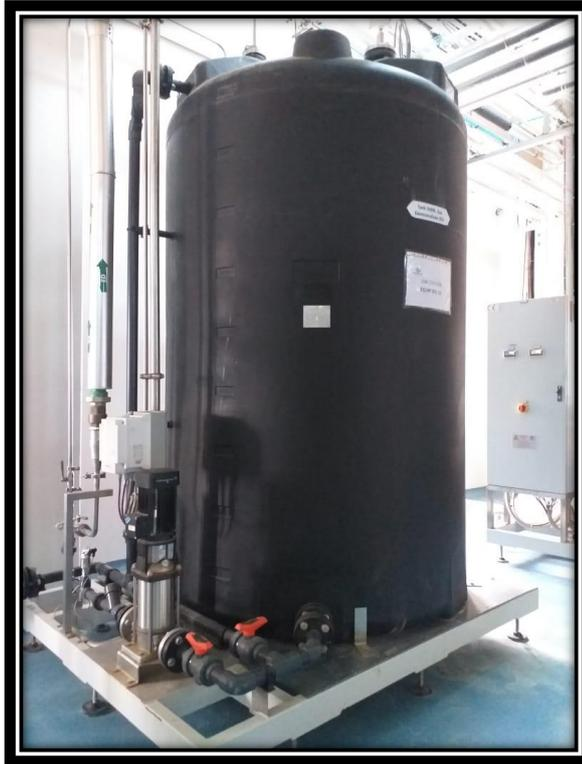
Figure 15 : Cuve de stockage
