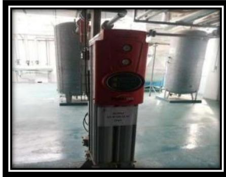
Figure 33 : Sécheur d'air
