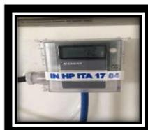
Figure 31 : Capteur de Pression
