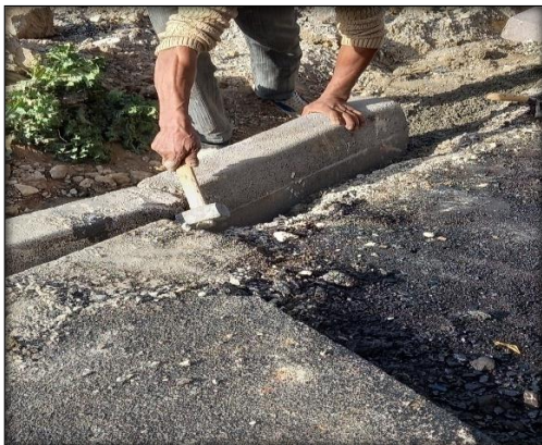
Figure 23 : Mise en place des bordures (T3)
