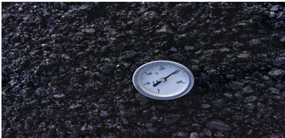
Figure 22 : enrobé (la température doit être entre 140°C et 180°C)
