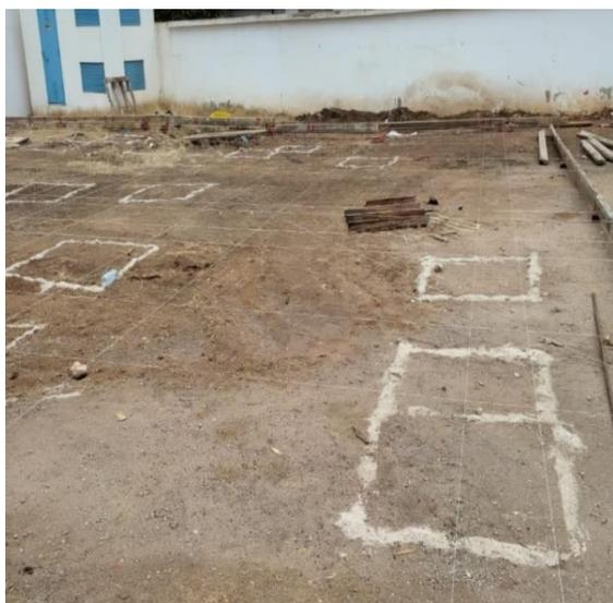
**Figure15 : Tracé des fouilles**
