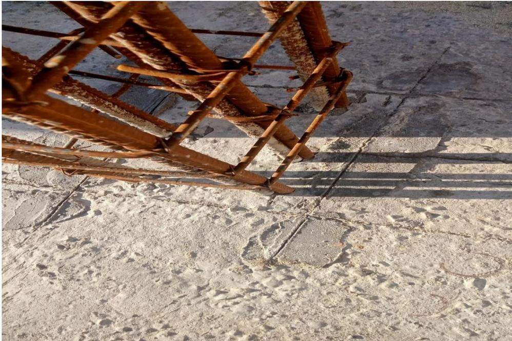
**Figure 29 : Traçage des axes sur une petite couche de mortier**
