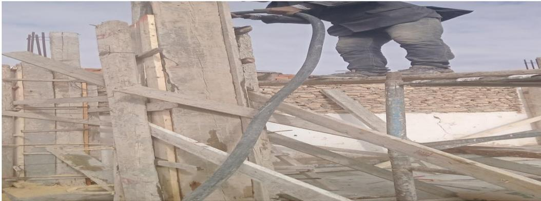
**Figure 33 : Vibration des poteaux**
