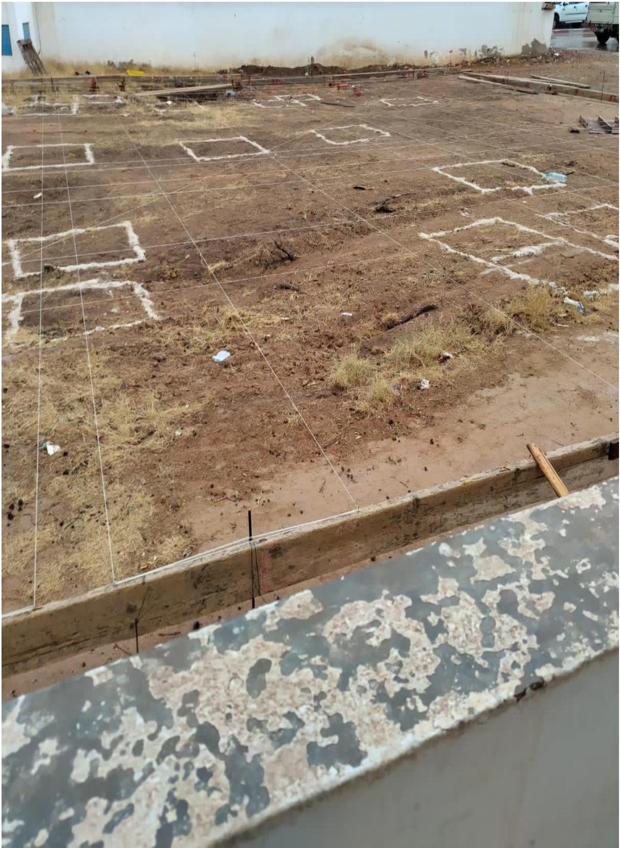
**Figure 14 : L'implantation le projet sur terrain**
