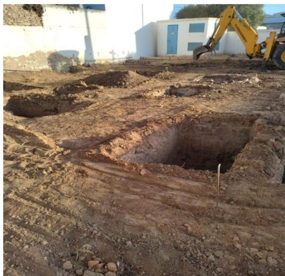
**Figure 16 : Excavation des fouilles**
