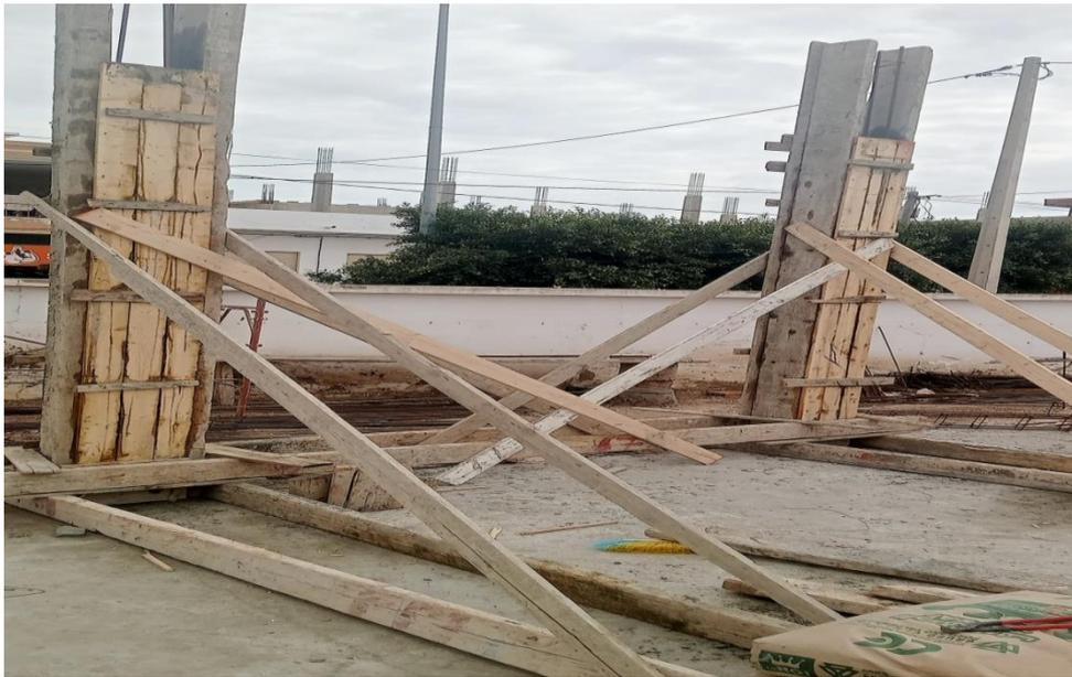
**Figure 31 : Coffrage des poteaux**
