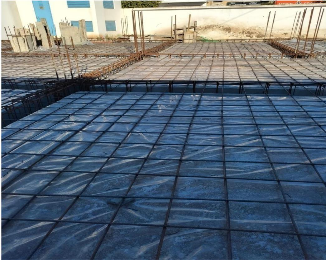
**Figure 27 : Pose le ferrailage de dallage**
