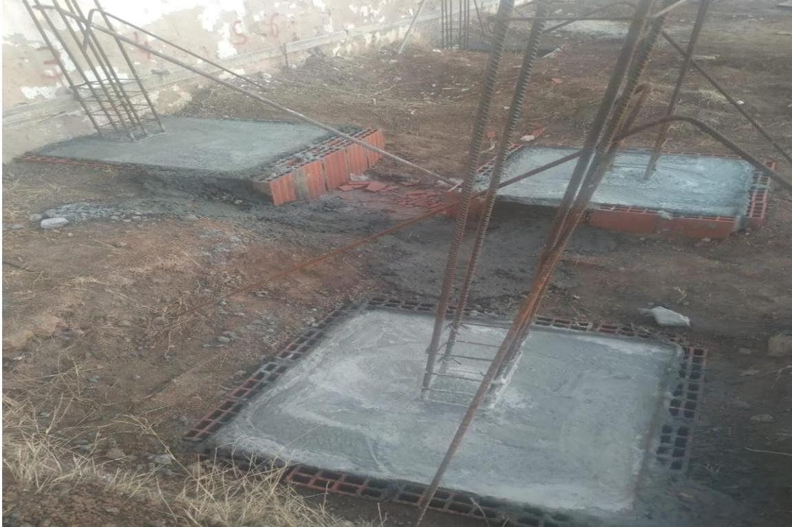
Figure 22 : Coulage du béton
