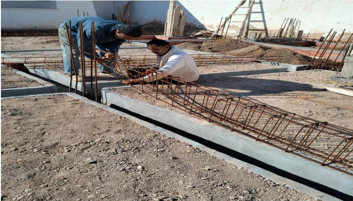
**Figure 26 : Mise en place le ferrailage de longrine**
