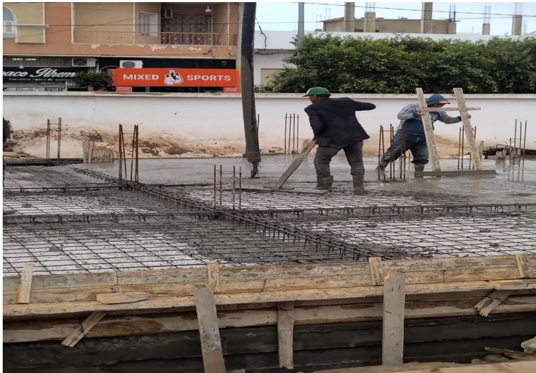
**Figure 28 : Coulage du béton**
