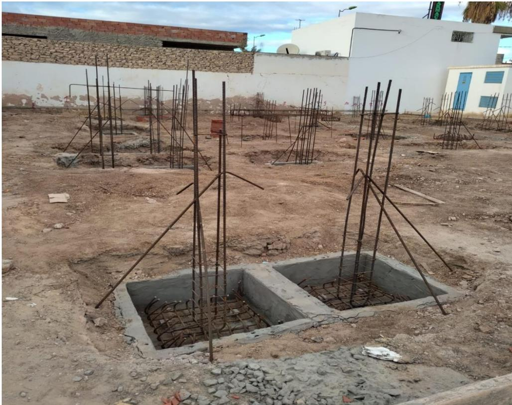
**Figure 21 : Mise en place le ferrailage**
