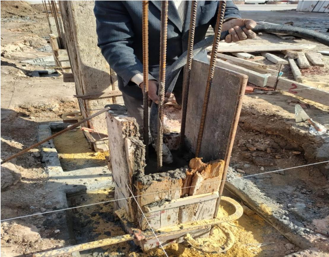
Figure 23 : Coffrage et bétonnage un pré poteau
