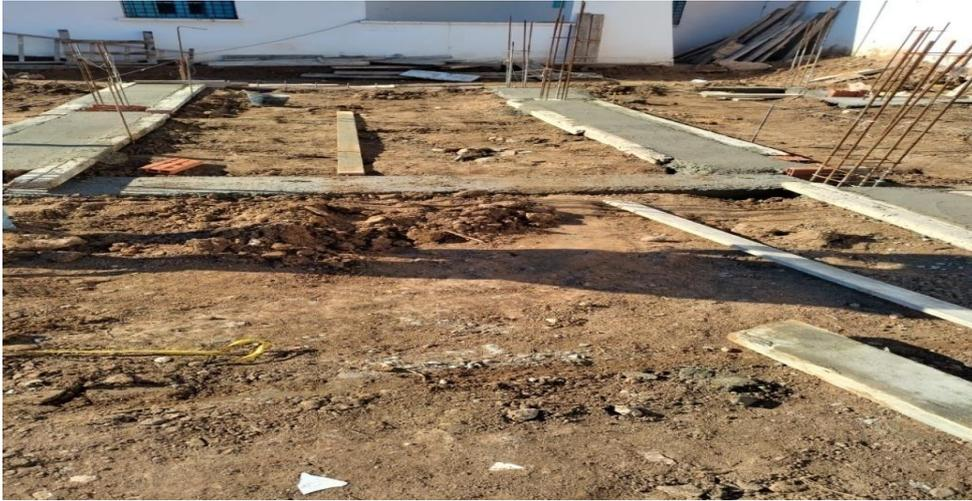
**Figure 24 : Coulage de béton de propreté**
