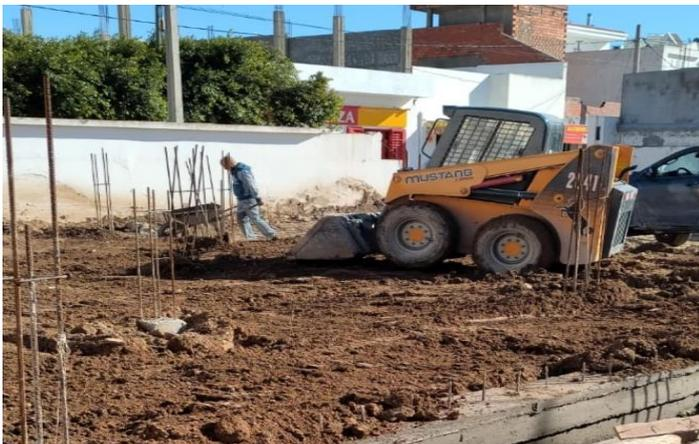
**Figure 5 : La mini chargeuse**
