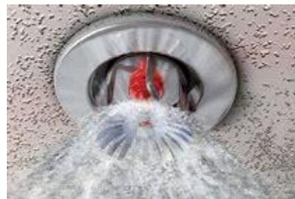
Figure 14 : sprinkler déclenché
